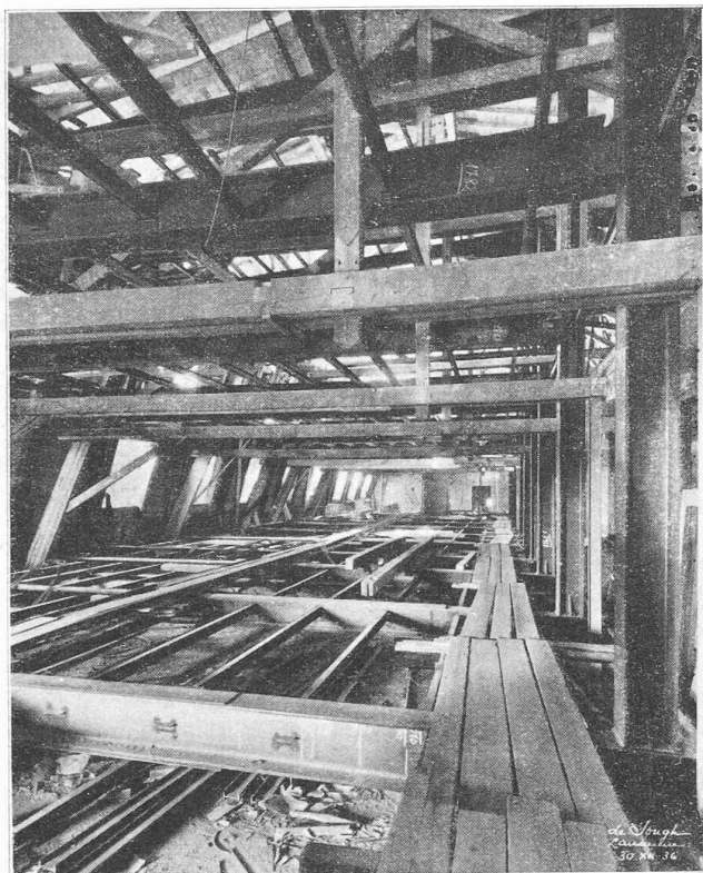
Fig. 4. — Vue du 4 me étage avant l'enlèvement des fermes en bois. Immédiatement au-dessus de l'entrait des fermes en bois apparaissent les sommiers du 5 me étage, dont on distingue les articulations qui les relient aux béquilles.
