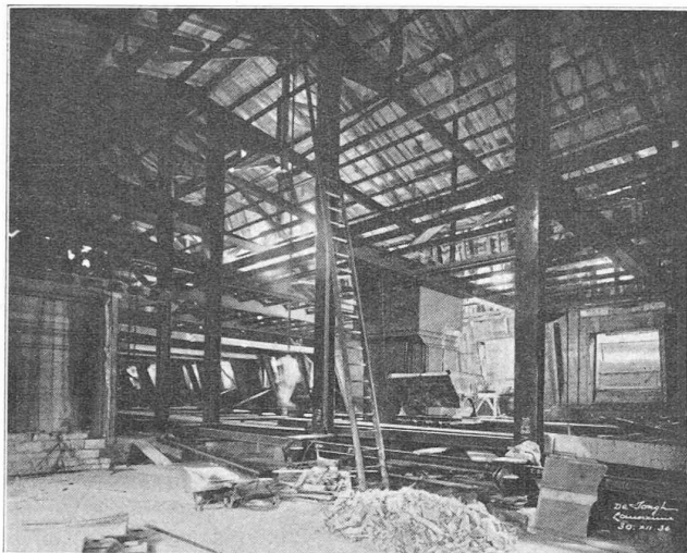
Fig. 1. — Vue d'ensemble de l'ossature des locaux sud avant la mise en place de la charpente des locaux nord.
