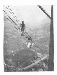
Fig. 7. — Montage d'un câble porteur.
