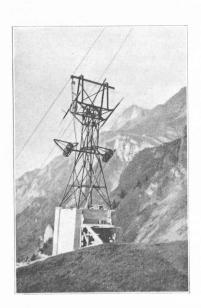
Fig. 5. — Pose de câbles sur les appuis du pylône.
