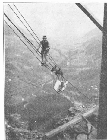
Fig. 7. — Montage d'un câble porteur.
