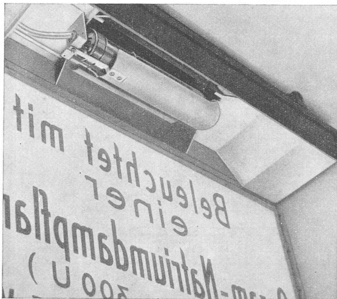
Fig. 1. — Vue de l'intérieur d'un transparent à double face éclairante.
