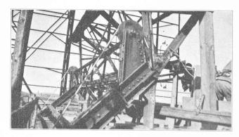
Fig. 6. — Fixation des câbles.
