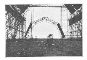
Fig. 8. — Descente d'un élément de ferme.
