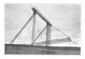
Fig. 13. — Basculement des panneaux des portes.
