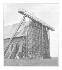
Fig. 4. — Pont transversal et porte roulante.
