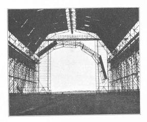
Fig. 7. — Descente d'un élément de ferme.
