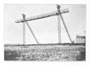
Fig. 14. — Descente d'un pont transversal.
