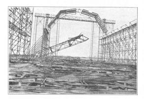
Fig. 12. — Démontage des éléments des parois.
