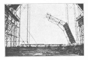
Fig. 10. — Basculement d'une moitié de ferme.
