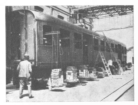
Fig. 4. — Essai de charge de la caisse modèle.
