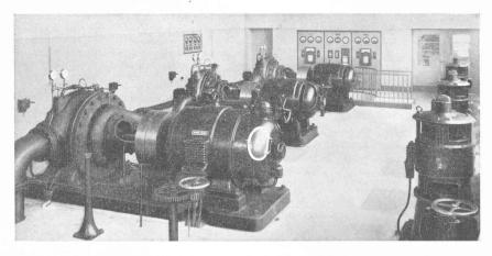
Fig. 5. — Station de pompage à Lutry, des Services industriels de Lausanne, équipée avec 2 télélimnigraphes et 1 conjoncteur-limnimètre Rittmeyer
