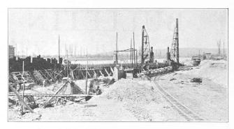
Fig. 9. — Partie aval du batardeau de rive droite. Au centre de la photo : pelle à vapeur. Photo Dyckerhoff & Widmann (Berlin).
