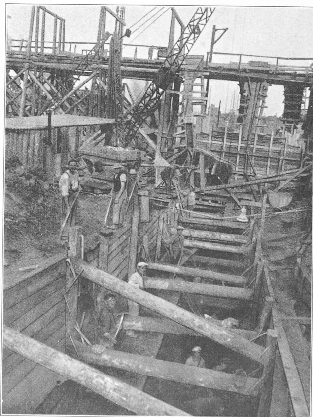
Fig. 12. — Fouille blindée du mur de rive droite amont. Photo Dyckerhoff & Widmann (Berlin).
