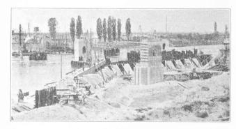
Fig. 10. — Batardeau de rive droite terminé. — Au centre de la photo : pile provisoire IV amont.
