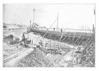
Fig. 8. — Partie amont du batardeau de rive droite (en cours d'exécution). Au centre de la photo : fondation de la pile provisoire IV amont. Photo Dyckerhoff & Widmann (Berlin).
