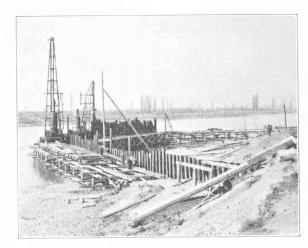
Fig. 7. — Exécution du batardeau de rive droite. (Vue prise d'amont). Photo *Dyckerhoff & Widmann* (Berlin).
