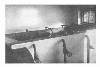
Fig. 16. — Flotteurs d'admission. Réservoir de Sonzier.
