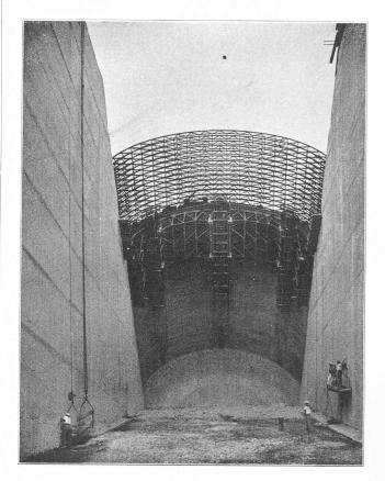
Fig. 20. — Vue du coffrage glissant suspendu aux fermes métalliques des voûtes.
