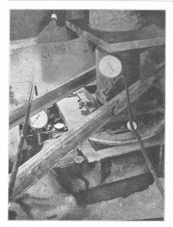
Fig. 7. — Dispositif permettant d'effectuer sur place des essais de cisaillement du sol de fondation.
