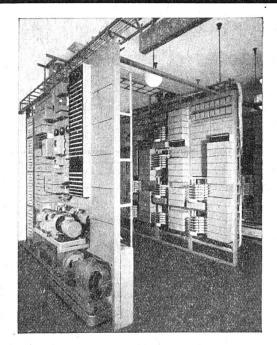
Nous construisons des installations téléphoniques de toutes grandeurs et en tous genres. Les figures représentent l'installation téléphonique de l'Ecole Polytechnique Fédérale à Zurich, se composant d'un central automatique pour 400 abonnés (en haut) et d'un commutateur à 16 lignes réseau (en bas) pour le trafic avec la ville.
