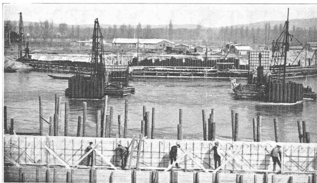
Fig. 5. — Exécution des piles provisoires II am. et II av. Au premier plan : Culée gauche.
