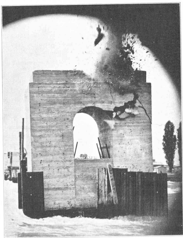
Fig. 6. — Démolition de la pile provisoire III av.
