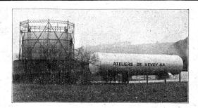
Capacités utiles comparées  $\begin{cases} gazomètre & 500 \text{ m}^3 \\ réservoir & 800 \text{ m}^3 \end{cases}$
