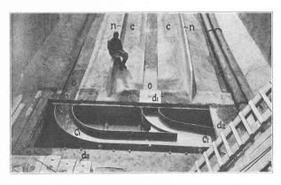
Fig. 6. — Partie aval du dessableur avec détails des orifices O-O, du canal collecteur  $C_1$ - $C_1$  et des dalles en béton armé  $d_1$  et  $d_2$  pour leur couverture.
