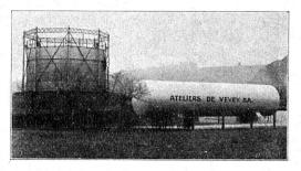
Capacités utiles comparées gazomètre 500 m³ réservoir 800 m³
