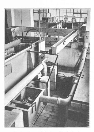
Fig. 4. — Vue générale du modèle (de l'aval). A. Galerie d'amenèc. — B. Epanouissement inférieur. — C. Epanouissements supérieurs. — D. Cheminée proprement dite. — E. Puits des vannes. — F. Conduite forcée. — G. Chambre supplémentaire en bout des épanouissements (solution abandonnée en définitive). — J. Vanne aval (distributeur). — K. Dispositif de réglage.
