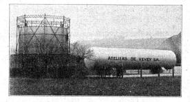
Capacités utiles comparées gazomètre 500 m² réservoir 800 m³
