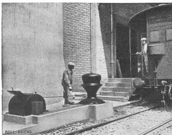
Fig. 2. — Cabestan avec enrouleur horizontal, demi-noyé.
