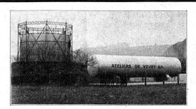
Capacités utiles comparées | gazomètre 500 m³ réservoir 800 m³
