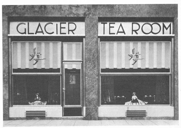
Devanture d'une confiserie. — Cadres en Anticorodal (oxydé anodiquement et colorié).
