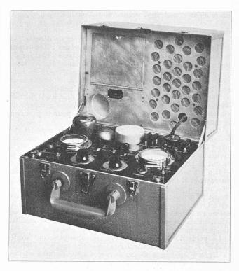
Fig. 2. — Amplificateur à lampes, pour « témoins sonores ».
