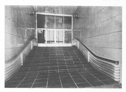
Fig. 2. — Rampes d'escalier à l'Ecole polytechnique fédérale. La rampe est constituée par les tuyaux en *aluman* du chauffage central.
