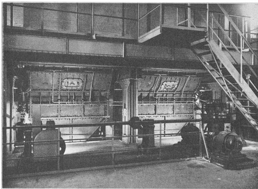
Fig. 4. — Fours Woodall-Duckham. Extraction du coke éteint.
