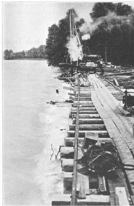
Fig. 4. — Pont de service et battage (marteau Pajot) du rideau principal de palplanches.
