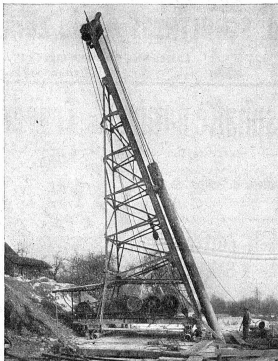
Sonnette Franki en position pour pieux inclinés.
