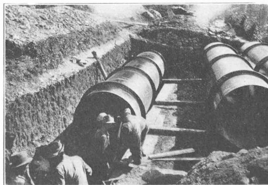
Fig. 17. — Chargement des tuyaux de Saleinaz.
