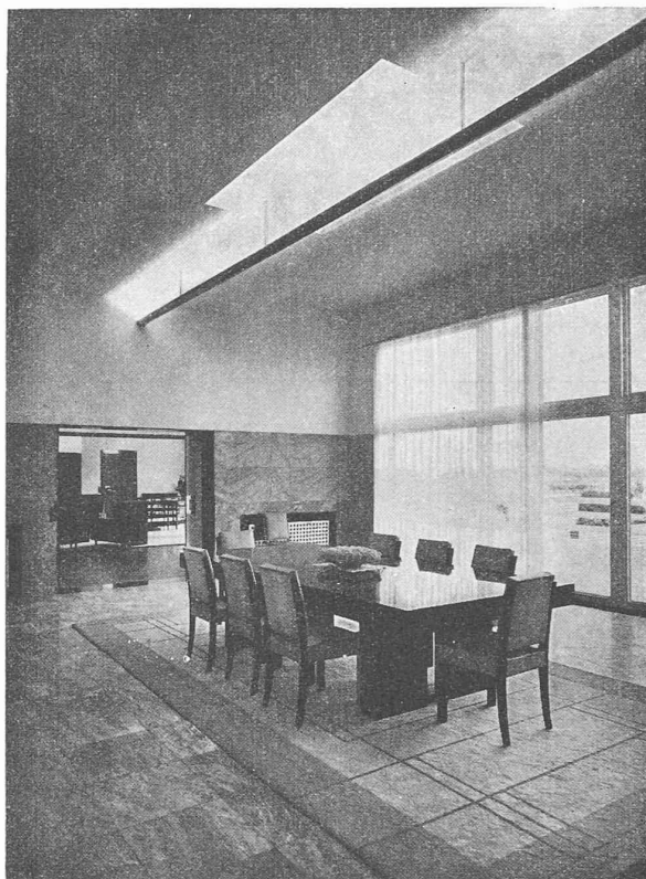
Fig. 6. — L'éclairage de la salle à manger par un ouvrage lumineux comportant des surfaces diffusantes.
