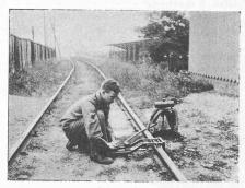
Fig. 3. - Foreuse « Ado » de trous d'éclisse.
