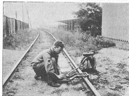
Fig. 3. — Foreuse « Ado » de trous d'éclisse.
