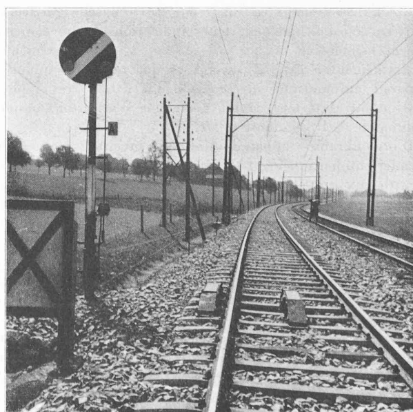
Fig. 2. — Aimants de voie avec signal avancé et contact.
