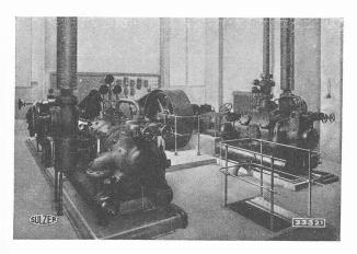
Fig. 2. — Compresseurs d'ammoniaque compound, construction Sulzer, pour la patinoire artificielle de Bâle. Pouvoir frigorifique de chaque machine 500 000 frig/h.
