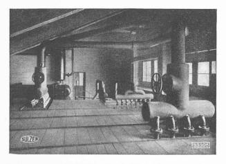
Fig. 6. — Couverture du réservoir refroidisseur de saumure, formant accumulateur de froid ; à gauche dans le fond le condenseur.
