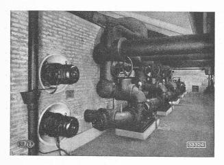
Fig. 5. — Pompes à saumure, installées dans la chambre des pompes de la patinoire artificielle de Bâle et servant à la circulation de la saumure dans les systèmes tubulaires de la piste. Au fond, les pompes de circulation d'eau.
