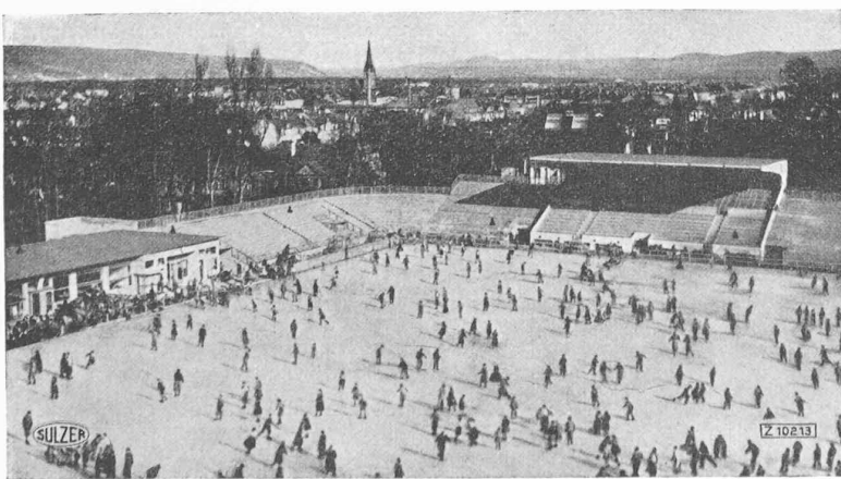
Fig. 1. — Patinoire artificielle, en plein air, de la ville de Bâle, équipée d'une installation frigorifique Sulzer comportant deux compresseurs d'ammoniac de 500 000 frig/h chacun.
