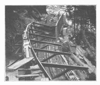
Fig. 1. — A Tæschwand (km. 31,7 environ). De la galerie de protection à colonnes, on passe à la galerie sous consoles métalliques ancrées dans des massifs-contrepoids en béton.
