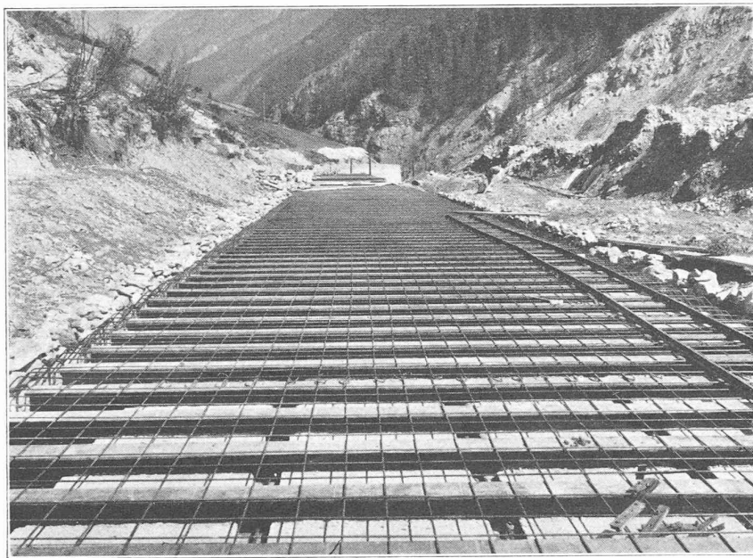
Fig. 3. — Km. 34,5, à Lugelwand, près de Zermatt. Construction du plafond du tunnel artificiel.
