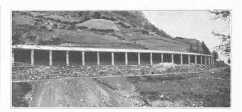
Fig. 2. — Km. 33,8, à Lugelwand, près de Zermatt. Galerie de protection contre les avalanches (sans chutes de pierres).
