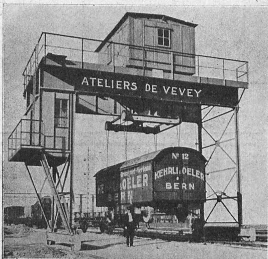
GRUE A PORTIQUE ROULANT, 40 T., DE LA GARE DE WEYERMANSCHAUS, A BERNE
