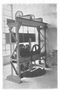
Fig. 24. — Chambre de mise en charge, vanne cylindrique.
