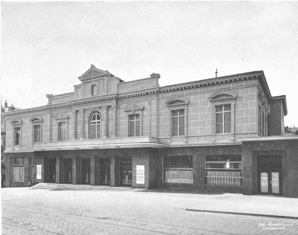
Ancienne façade, rénovée. Entrée principale. THÉÂTRE MUNICIPAL DE LAUSANNE. Architecte : M. Ch. Thévenaz.
