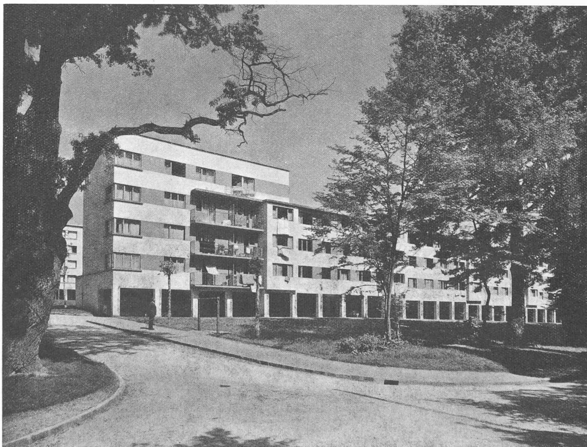
Fig. 6. — Cité Vieusseux, à Genève. Groupe F. Façade principale. — M. Maurice Braillard, architecte.
