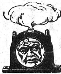
Marque de fabrique Palier échauffé
