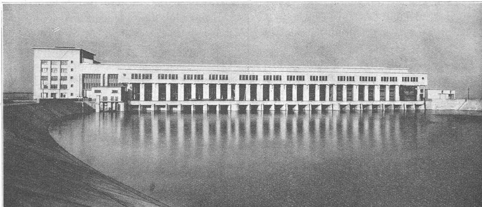
Fig. 5. — Vue générale de l'usine, prise d'amont.
