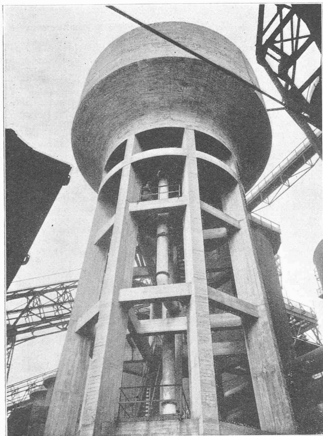
Fig. 11. — Château d'eau, d'une capacité de 1000 m 3 , de la Société des Forges de Clabecq.
