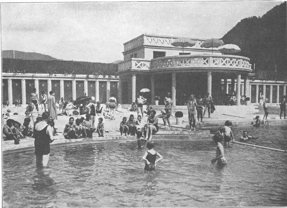
Fig. 11. — Piscine de Gstaad. Constructeur : M. B. Hefti.
