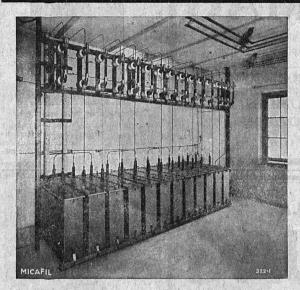
Batterie de condensateurs à haute tension MICAFIL, pour l'amélioration du racteur de puissance.
