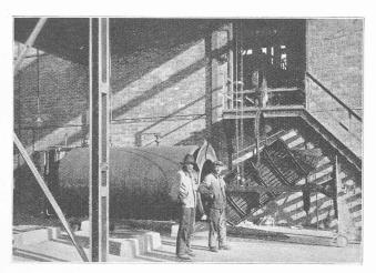
Fig. 4. - La chaudière d'extinction du coke.
