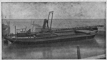
Déchargeur flottant avec élévateur, tapis et treuil roulants.
