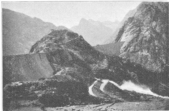
A droite, le barrage de la Spitallam, le plus haut. A gauche, le barrage de Seeuferegg, le plus long.
