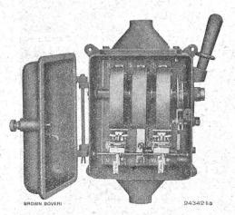
Coffret de manœuvre à déclencheurs thermiques.
