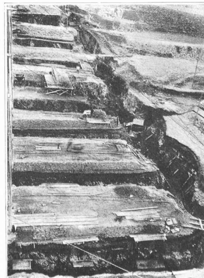
A gauche. Barrage en voûte sur la Bromme (France). Joints dans le granite d'appui. L'étanchement par injection a été absolu. (Cliché «Société générale d'entreprises».)
