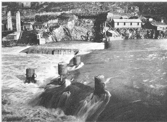
Barrage de Pinet sur le Tarn. Les sas des caissons pendant une crue de 800 m 3 , le 21 décembre 1927. (Cliché «Energie électrique du Rouergue S. A.».)
