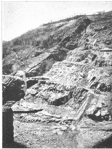
A gauche. Barrage du Sautet, sur le Drac. La gorge qui sera barrée et le pont-route. A peu près en dessous de la culée du pont, deux carrés noirs. Ce sont, le long de l'appui, les plateformes pour les appareils de forage et d'injections exécutées par G. Rodio & C ie . (Cliché de la «C ie Bonne et Drac», à Grenoble.)
