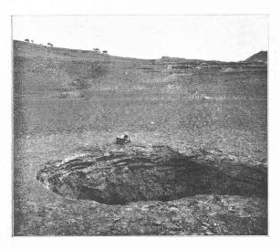
Retenue de Monte-Jaque. Ouverture soudaine sur le fond de la retenue après quelques jours de remplissage. La perte s'est fait jour à travers de l'argile recouvrant directement le calcaire fissuré. (Cliché M. Lugeon)
