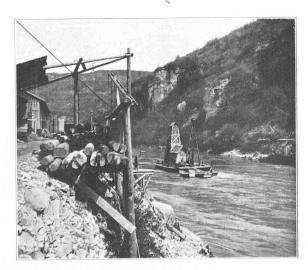
Barrage de Génissiat sur le Rhône. Installation pour les sondages aux rails en 1920. A gauche barraquement pour le fonçage du puits et la galerie sous le Rhône. (Cliché M. Lugeon.)
