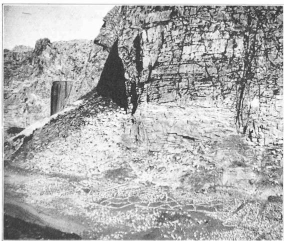
Retenue de Monte-Jaque. Corroyage du fond de la cuvette, décapage des parois pour le jointoyage au mortier des fissures. Au fond le barrage. (Cliché M. Lugeon.)
