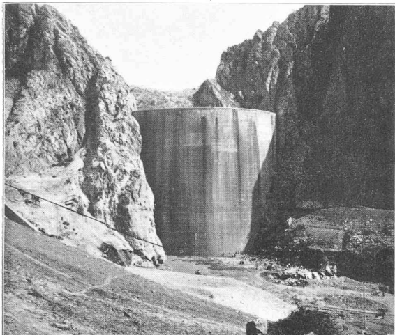
Barrage-voûte de Monte-Jaque. (Andalousie). Pas d'eau dans la retenue. A droite parois de calcaires jurassiques absorbants. (Cliché M. Lugeon.)
