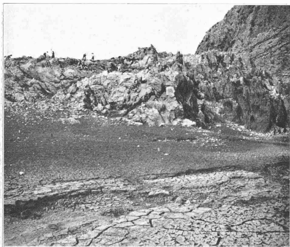
Retenue de Monte-Jaque. Calcaires jurassiques absorbants. Ouvriers occupés à obturer les fissures. (Cliché M. Lugeon.)
