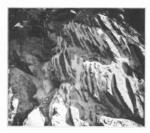
Retenue de Monte-Jaque. Jointoyage au mortier de fissures du calcaire. (Cliché M. Lugeon.)
