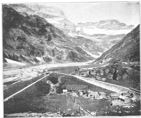
Barrage de Barberine. La cuvette de la future retenue. Au fond, au-dessus de l'alluvion, parois calcaires qui ont été noyées sans fuite. (Cliché M. Lugeon.)
