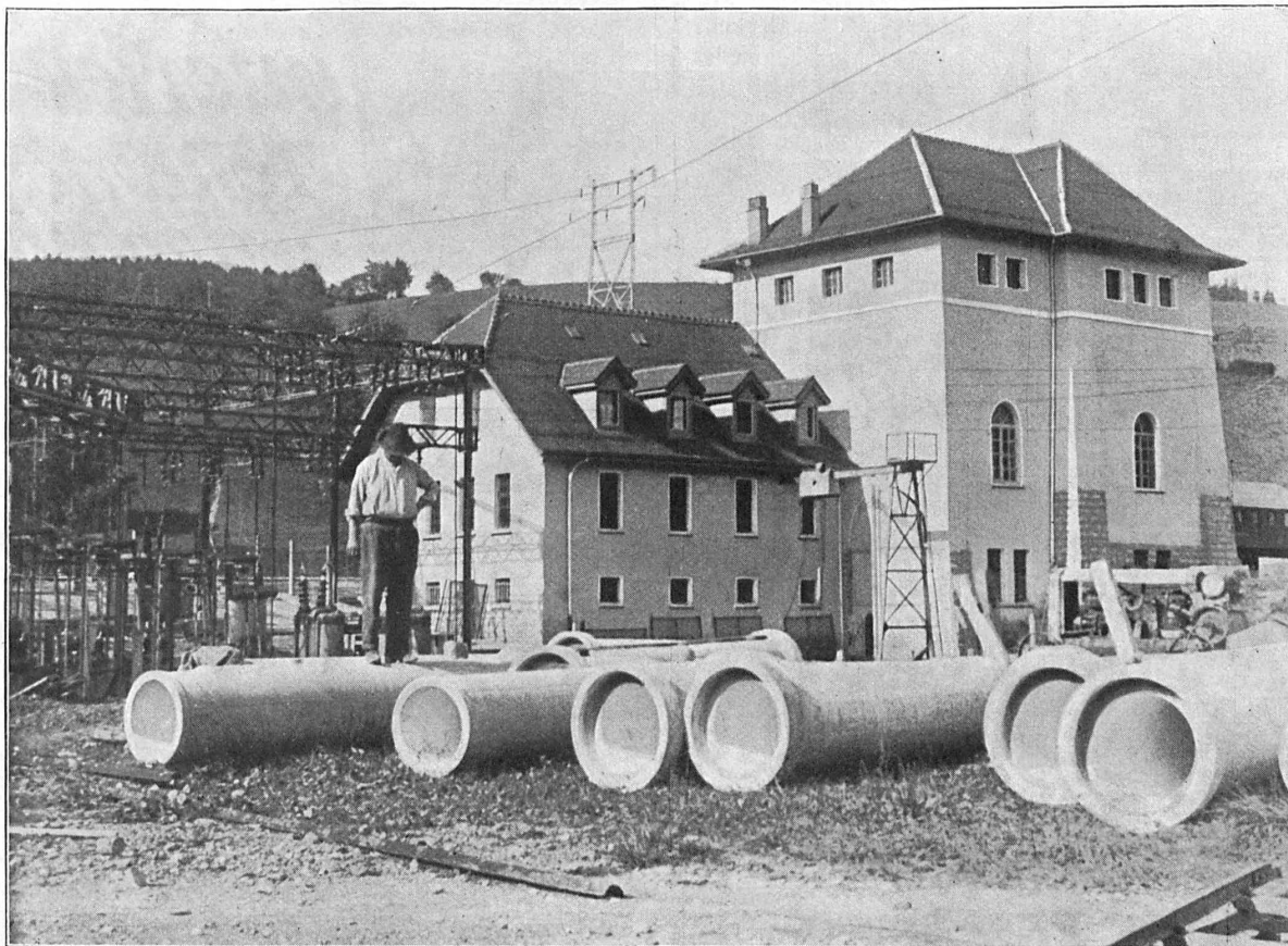
Sous-station de Puidoux des C.F.F., canalisation de 500 mm., en tuyaux Vianini, posée à une profondeur de 7 mètres en terrain marneux.
