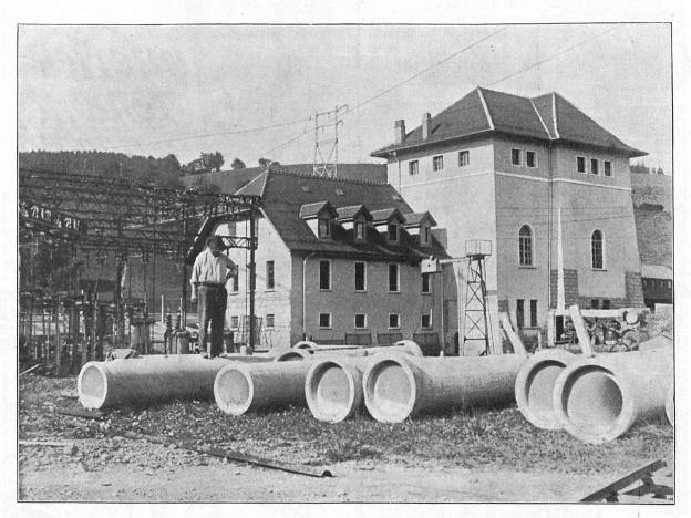
Sous-station de Puidoux des C. F. F., canalisation de 500 mm., en tuyaux Vianini, posée à une
