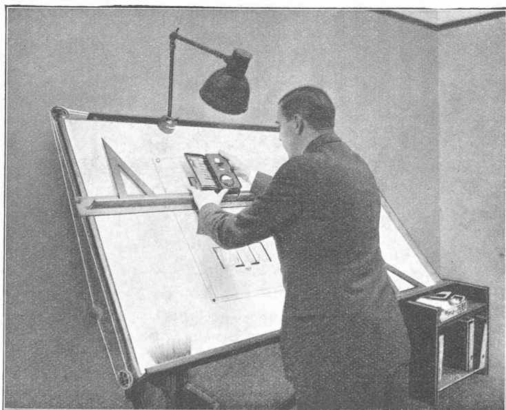
Fig. 8. — Mesure de l'éclairement d'une table à dessin inclinée.
