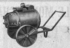
La soudure autogène électrique par courant continu
