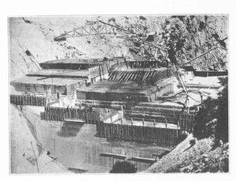
Fig. 5. — Barrage de l'Oued Fodda (bétonnage).
