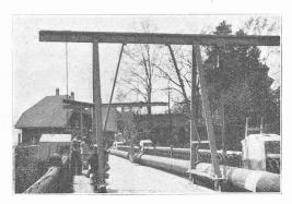
Dispositif ayant permis la pose rapide des tuyaux traversant la voie ferrée, au pont du Languedoc. Les C. F. F. avaient naturellement coupé le courant pendant cette opération.
